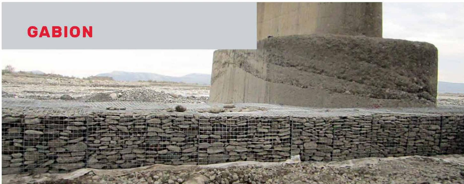
Grâce à sa structure, elle est utilisée notamment contre les chutes de pierres sur les autoroutes et voies ferrées. Facile d'utilisation, durable et sans entretien, la cage à gabion est également utilisée pour les murs de soutènement, bordures, protections côtières...
